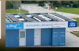
Photovoltaik, auch für die Gebäude im Hafendorf Müritz Niderviller hat schon seit 2014 Solarthermie. Energieeinsparung dank LED-Beleuchtung und Kraft-Wärme-Kopplung
